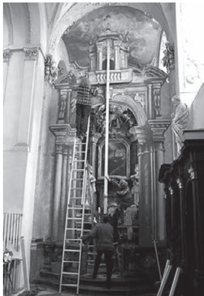
Obr. 4 – První stavba 2010 byla ve výšce 6 metrů velmi odvážná, dnes se používá mobilní lešení.
